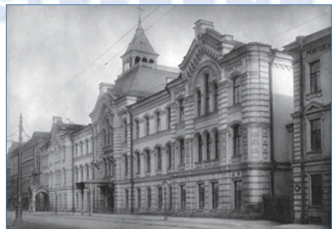
1-я Рота Измайловского полка. Вид фасада здания Ремесленного училища цесаревича Николая в начале 1900-х годов
